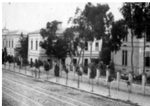
Figura 7: Los pabellones del antiguo “Hospital Buenos Aires”, sobre la calle Córdoba, entonces empedrada. El tosco empedrado está surcado por bandas lisas por las que trataban de circular los carros de manera más suave (año 1885).
