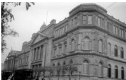
Figura 9: El edificio se ha ampliado hacia la calle Junín y ocupa toda la manzana (año 1910)
